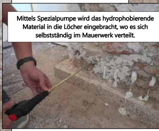
Mittels Spezialpumpe wird das hydrophobierende Material in die Löcher eingebracht, wo es sich selbstständig im Mauerwerk verteilt.
